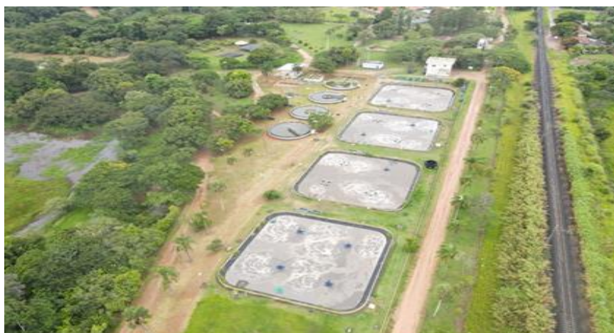
Figura 1: Foto aérea da ETE Camanducaia
