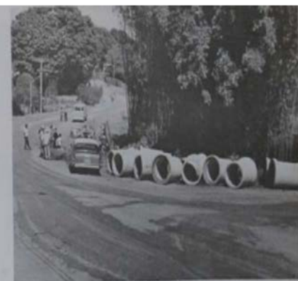
ESTRADA DO TRAVIÚ CAPTAÇÃO DE ÁGUAS PLUVIAIS E INÍCIO DO ASFALTAMENTO
