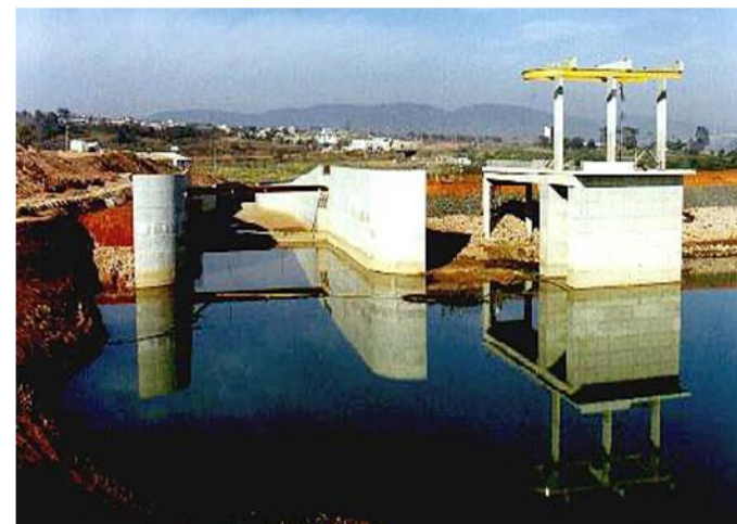
EXTRAVASOR DA REPRESA DE ACUMULAÇÃO
