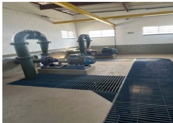
CASA DE BOMBAS E CONTROLE DE JUNDIAÍ R13
