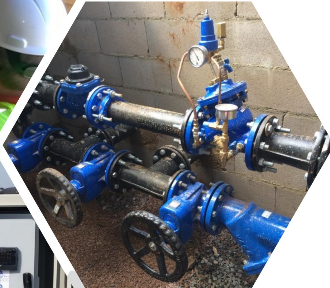
Após a substituição completa da infraestrutura, medidores de vazão e válvulas redutoras de pressão são instalados nas redes adutoras que abastecem o setor.
