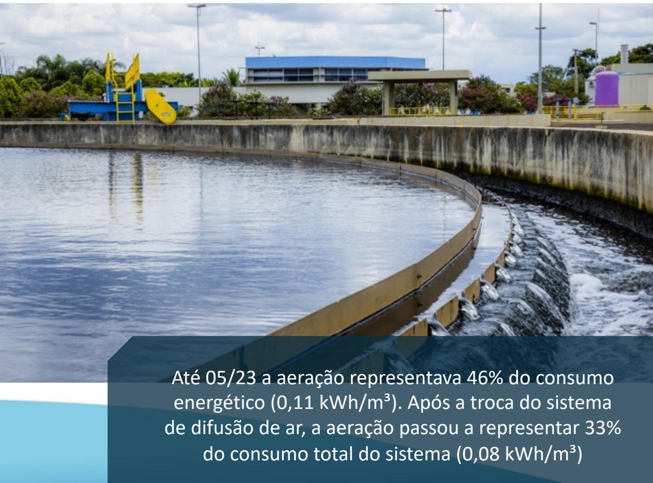
Até 05/23 a aeração representava 46% do consumo energético (0,11 kWh/m<sup>3</sup>). Após a troca do sistema de difusão de ar, a aeração passou a representar 33% do consumo total do sistema (0,08 kWh/m<sup>3</sup>)
