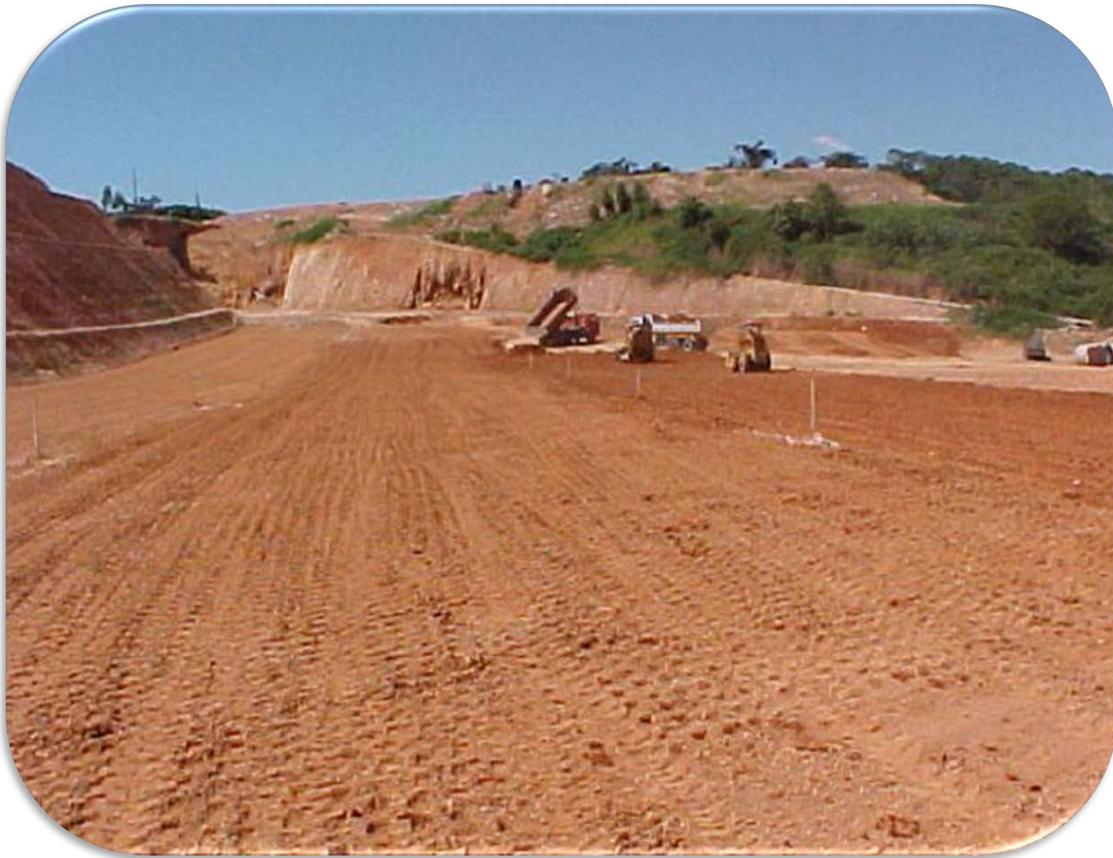
Impermeabilização de Fundo com Argila
