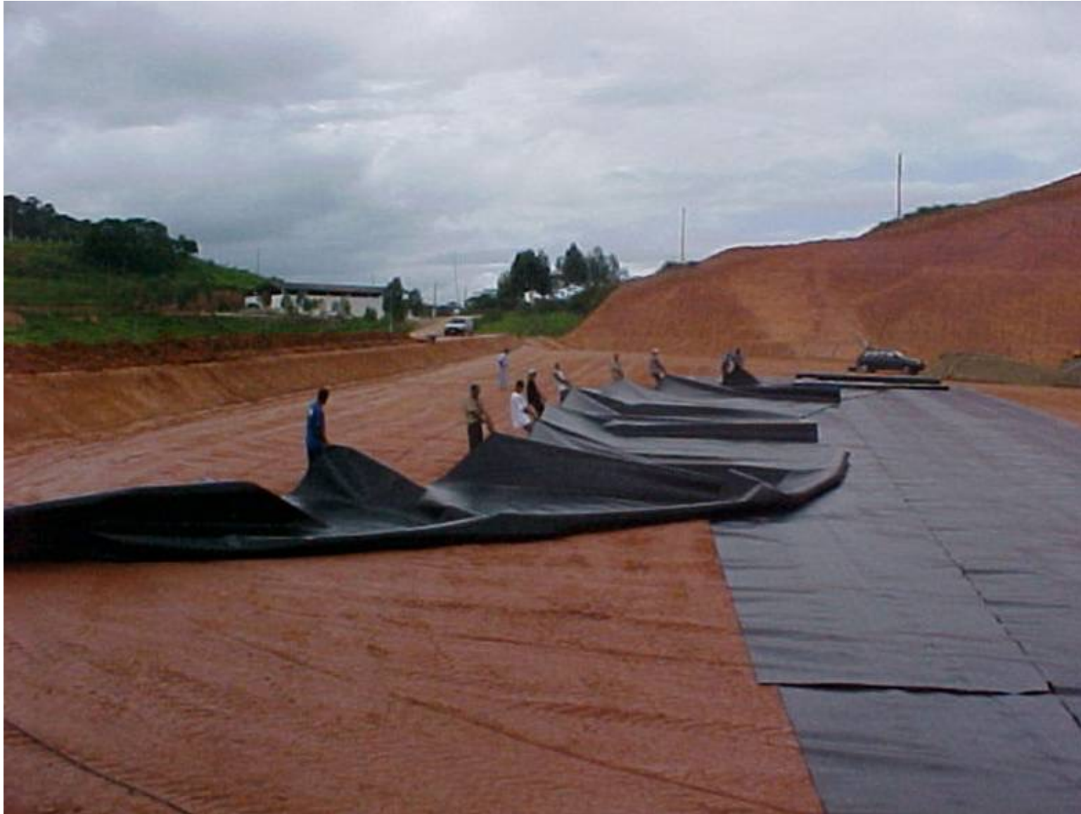
IMPERMEABILIZAÇÃO COM MANTA DE P.E.A.D (INÍCIO DAS INSTALAÇÕES)
