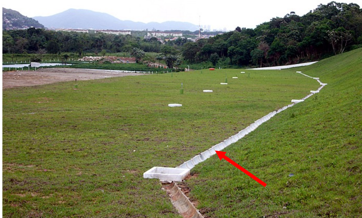
Aterro Sanitário do Saco do Funil - Guarujá, SP. Monitoramento geotécnico do maciço de resíduos recuperado.
