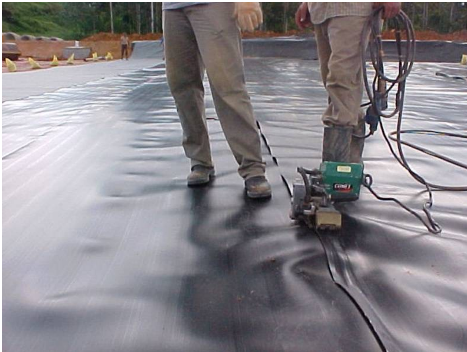
SOLDA POR TERMOFUSÃO
