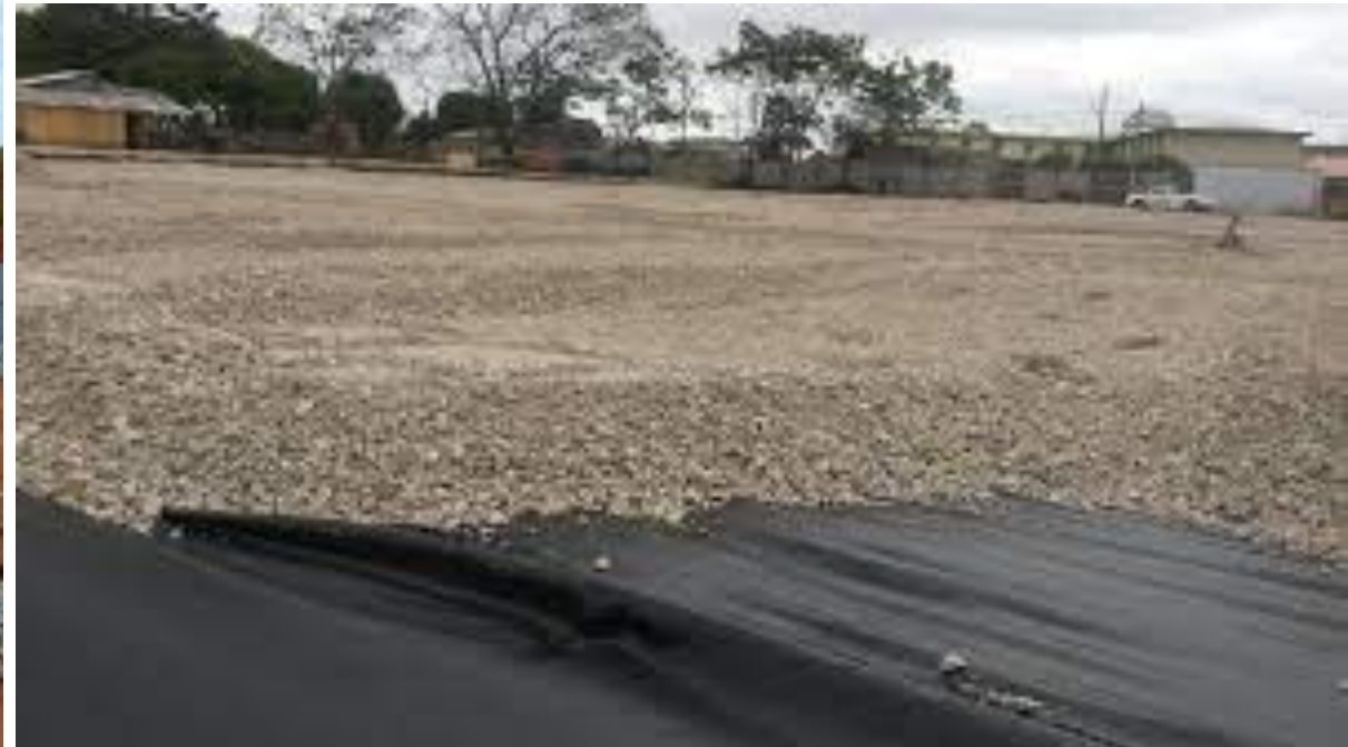
Drenagem com o sistema colchão drenante
