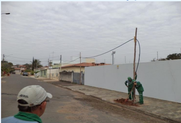
REDE PROVISÓRIA – “by pass”
