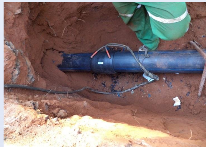
SOLDA POR ELETROFUSÃO
