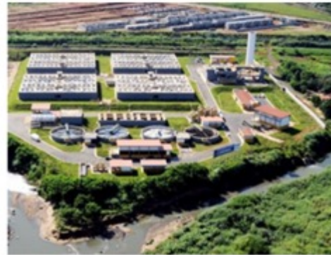
ETE ANHUMAS UASB + FÍSICO QUÍMICO 1200 l/s
