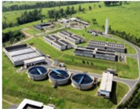
ETE PIÇARRÃO UASB + LODOS ATIVADOS 417 l/s
