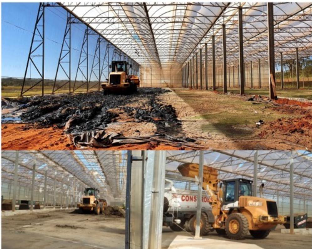
Figura 4: Pá carregadeira realizando o revolvimento do material.
