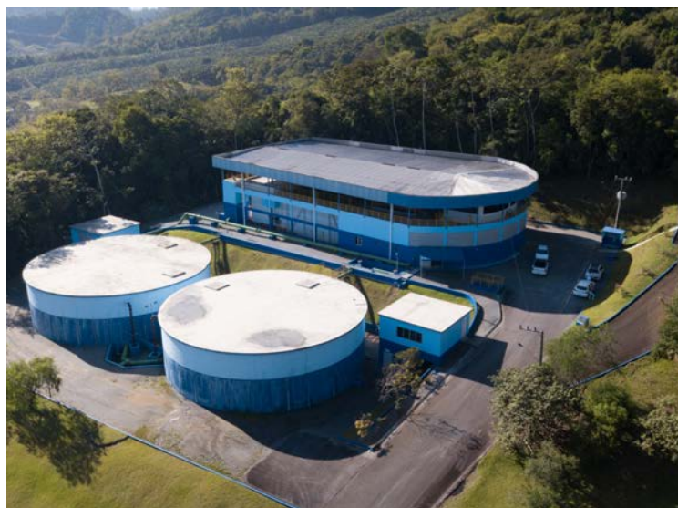
ETA SUL - 160 L/s – 20% da cidade Inaugurada em 2011 Rio Jaraguá
