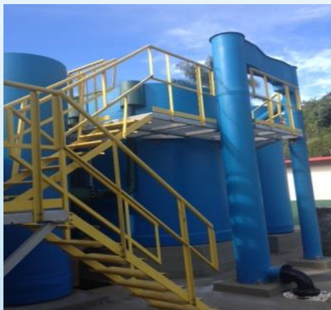
Apoio na Concretização da ETA de Rio Doce
