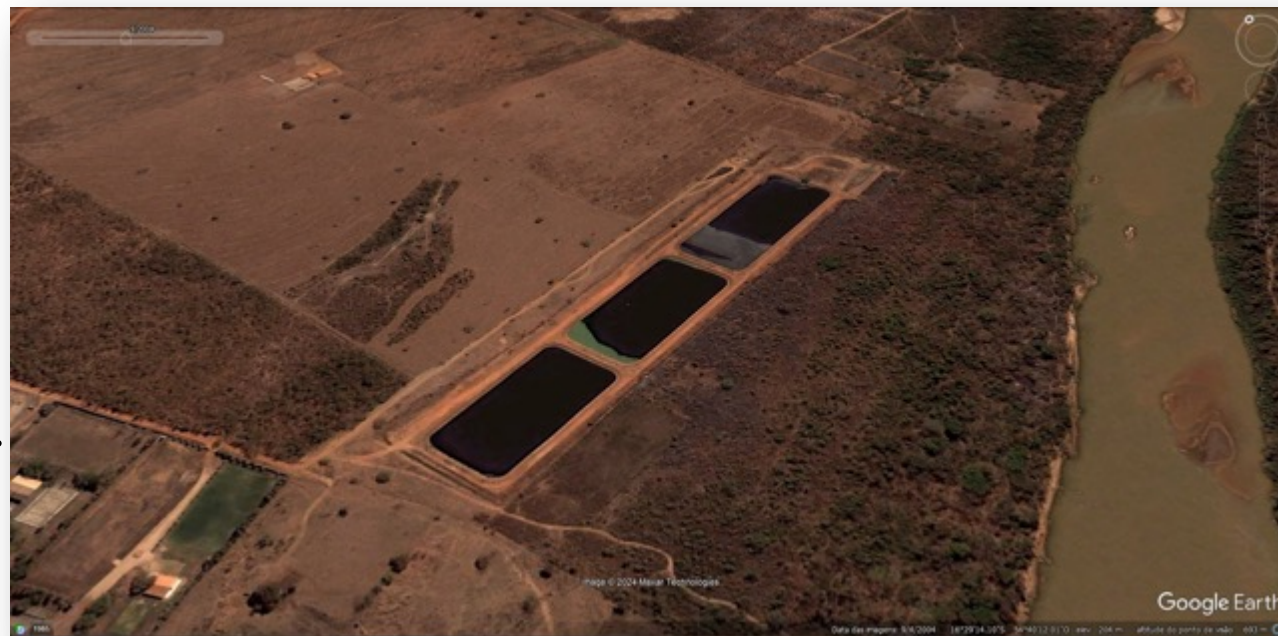
Estação de Tratamento de Esgoto no ano de 2005
