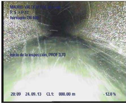
Foto: 12_12_43_A.JPG, VCR No: AVISO 0m, Inicio de la inspección
