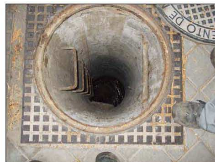
Foto: P. 12 C.jpg, VCR No: AVISO 27,1m, Fin de la inspección
