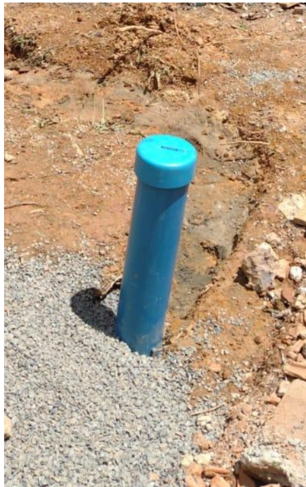
Poço semi artesiano instalado na Fazenda Souza Lima.
