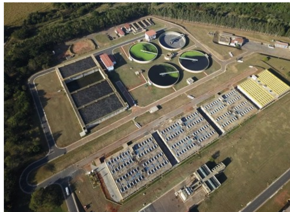
Figura 1: Vista aérea da ETE Rio Preto.
