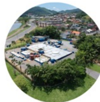
ETE Ilha da Figueira
