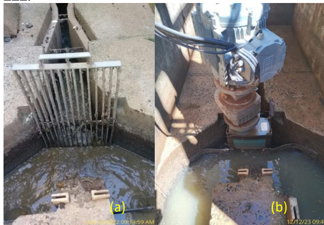
Figura 1 – Gradeamento (a) e triturador (b) instalado na EEE.
