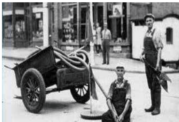
FIGURA 100 - SISTEMA DE LIMPEZA DAS REDES DE ESGOTO IMPLANTADO EM LONDRES A PARTIR DE 1859.
