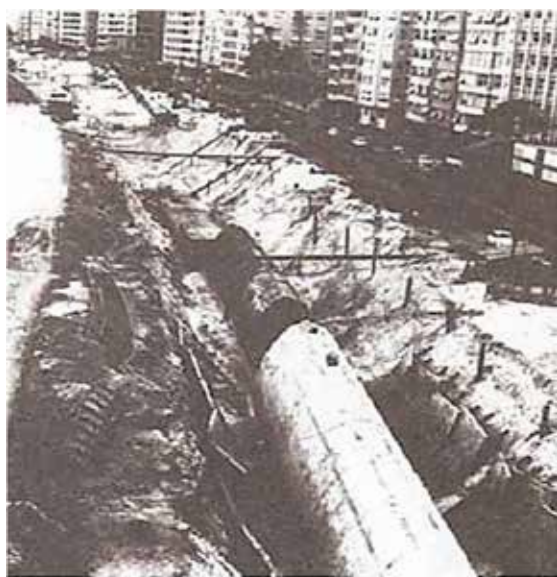
Figura 04- Parte da construção do Interceptor Oceânico na Av. Atlântica. Álbum de construção do IO, Departamento de Saneamento/ Sursan, 1971 (SILVA, 2002, VI).
