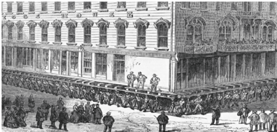
FIGURA 92 - IÇAMENTO DO BRIGGS HOUSE - 1857
