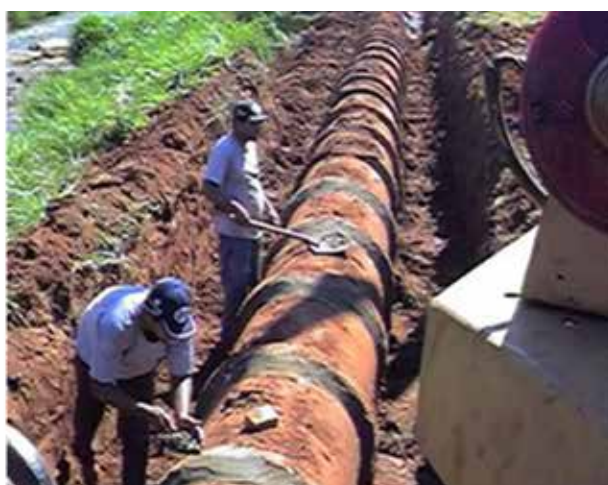
FIGURA 168 - PRIMEIRAS OBRAS DE REPAROS EM INTERCEPTORES DE ESGOTO
