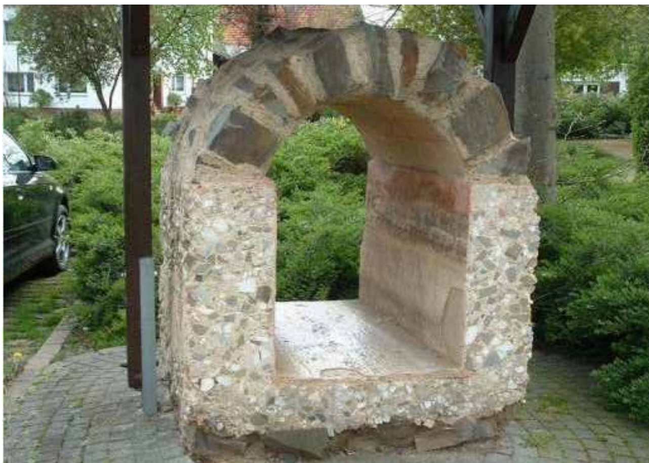
FIGURA 36 - SEÇÃO TÍPICA DO AQUEDUTO DE EIFFEL - BONN ALEMANHA
