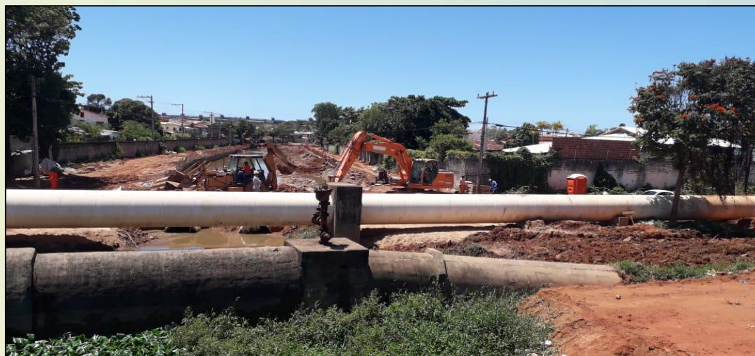
Figura 20: Canal em execução com destaque para a adutora Joanes Bolandeira
