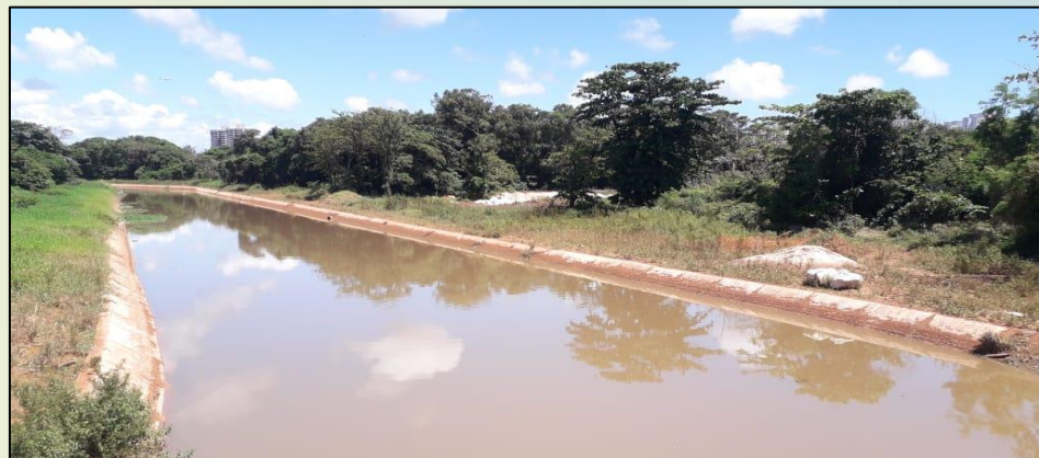
Figura 19: Trecho do Rio Jaguaribe já canalizado
