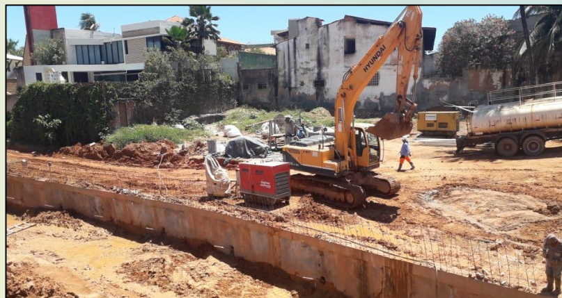
Figura 2: Máquinas de escavação e trabalhadores no canal do Rio Jaguaribe
