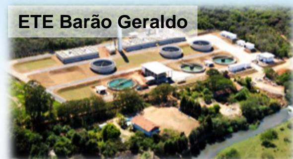
Digestor Anaeróbio de Fluxo Ascendente com manta de Lodo, Filtro Biológico Percolador de Alta Taxa e Decantação Secundária
