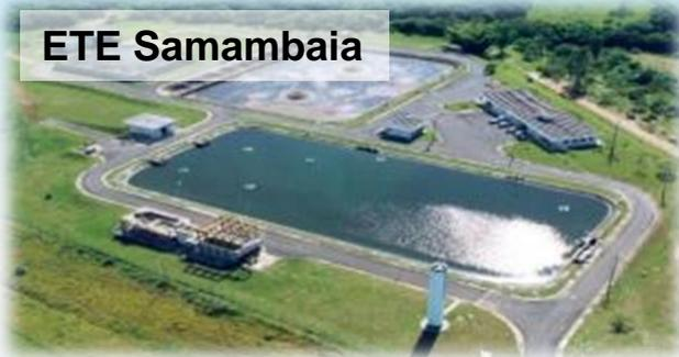
Lagoas Aeradas, Decantador Secundário e Digestor Aeróbio de Lodo
