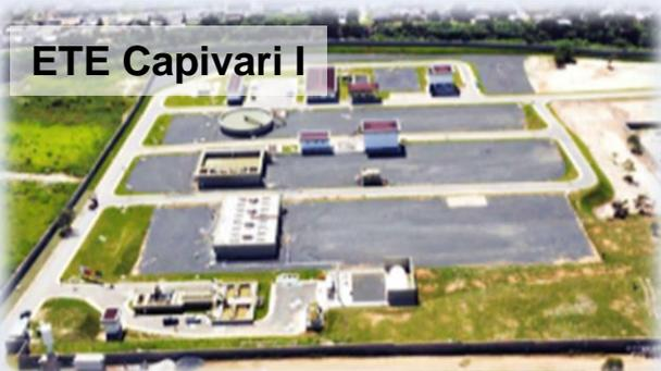
Digestor Anaeróbio de Fluxo Ascendente + Manta de Lodo, Tanque Anóxico, *Moving Bed Biological Reactor*, Decantação Secundária+Desinfecção
