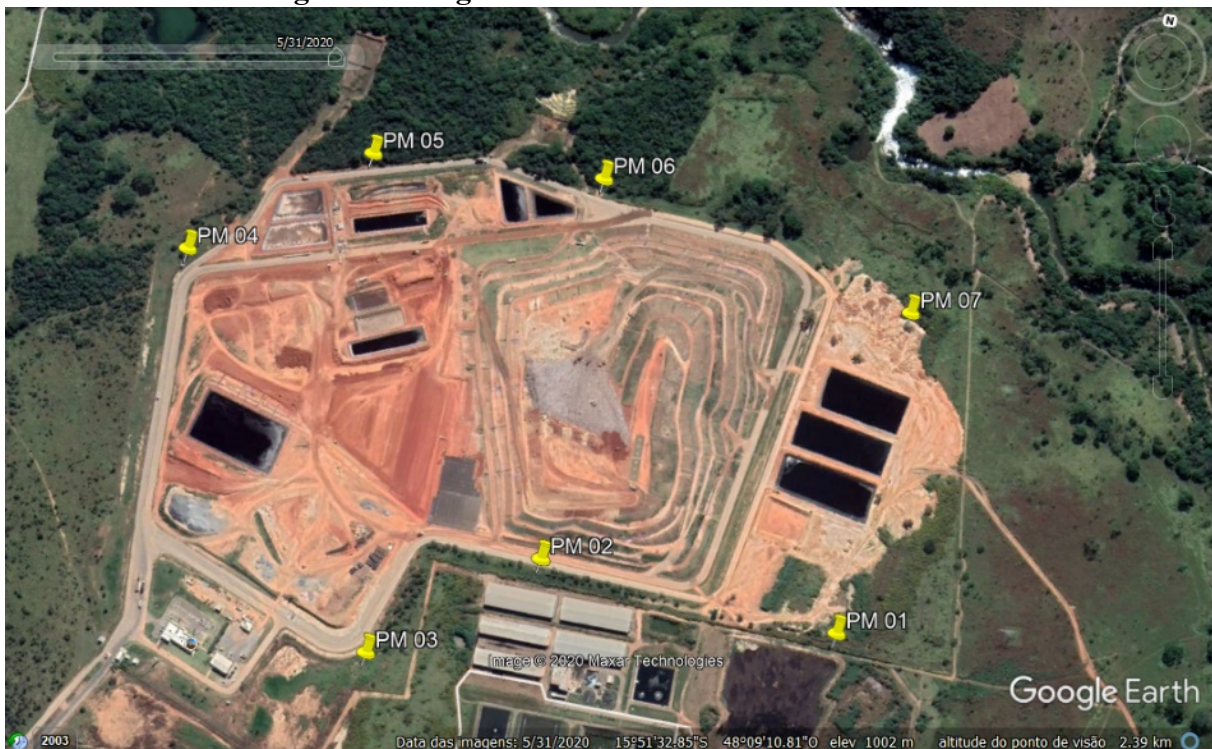
Figura 1- Imagem do Aterro Sanitário de Brasília.
