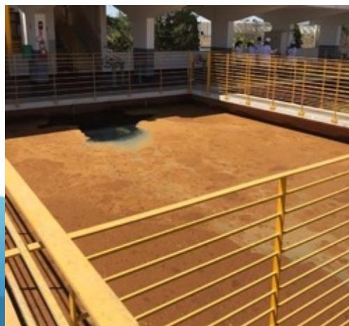
**Flotação nos decantadores e carregamento para os filtros, obstruindo-os em poucas horas de funcionamento;**
