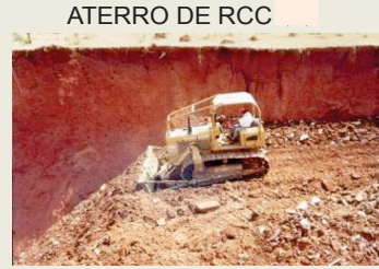
ATERRO DE RCC Futura exploração com equipamento triturador (Consórcio)
