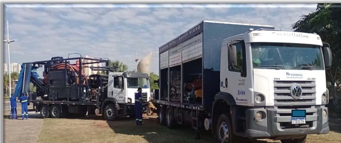
CONJUNTO HIDROJATO – “LIMPEZA TOTAL”
