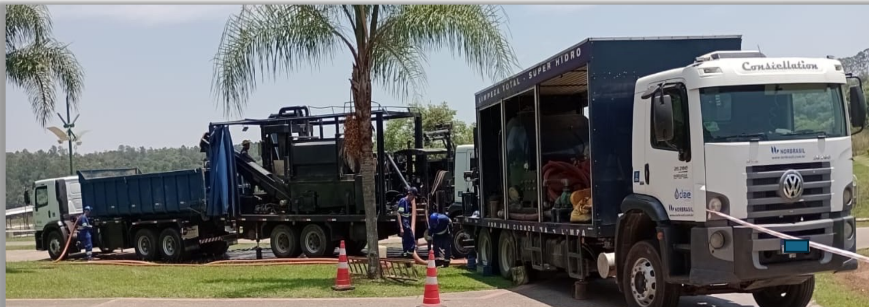
CONJUNTO HIDROJATO – “LIMPEZA TOTAL”
