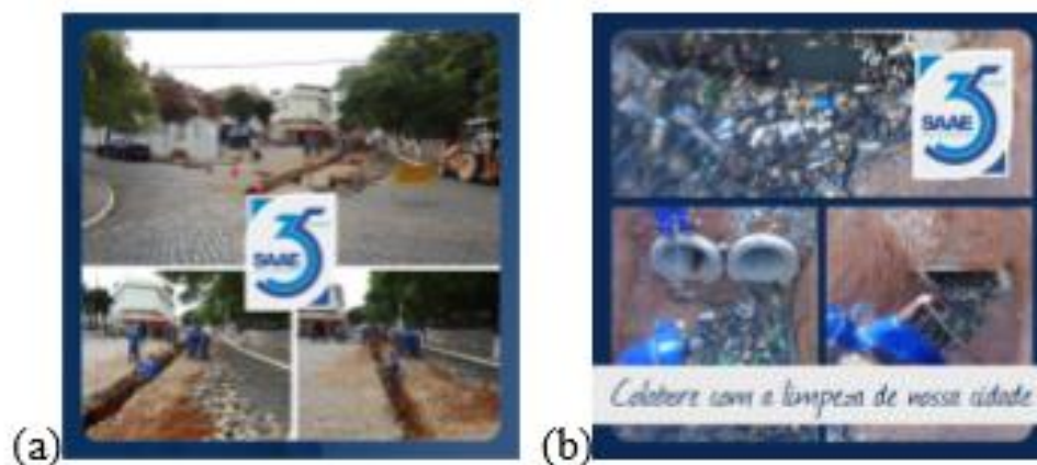
Figura 2 - Recuperação e construção de captação de esgoto na cidade (a); Limpeza de canalização de drenagens pluviais já existentes bem como recuperação dessas (b).
