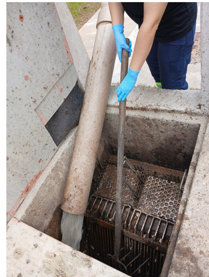
Limpeza do gradeamento
