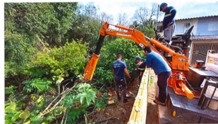
Imagem 3: Limpeza para identificação da rede.
