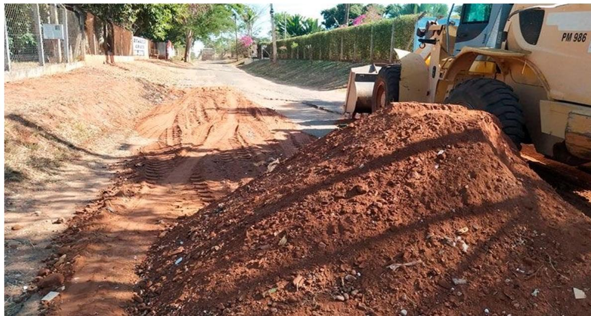
Figura 10 – Recuperação de Via com Agregado Reciclados – Fonte:
