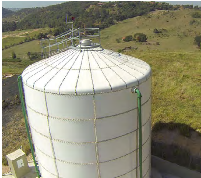
Cobertura de chapa parafusada (revestimento = costado)
