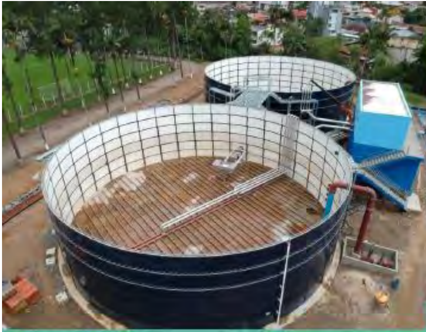
Base em Concreto
