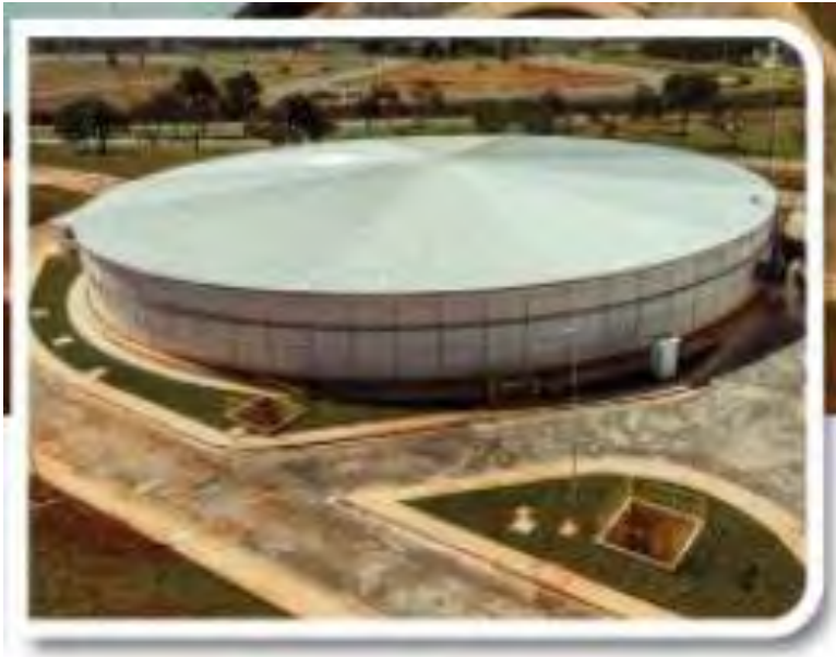
Cobertura sempi plana (telha de alumínio)
